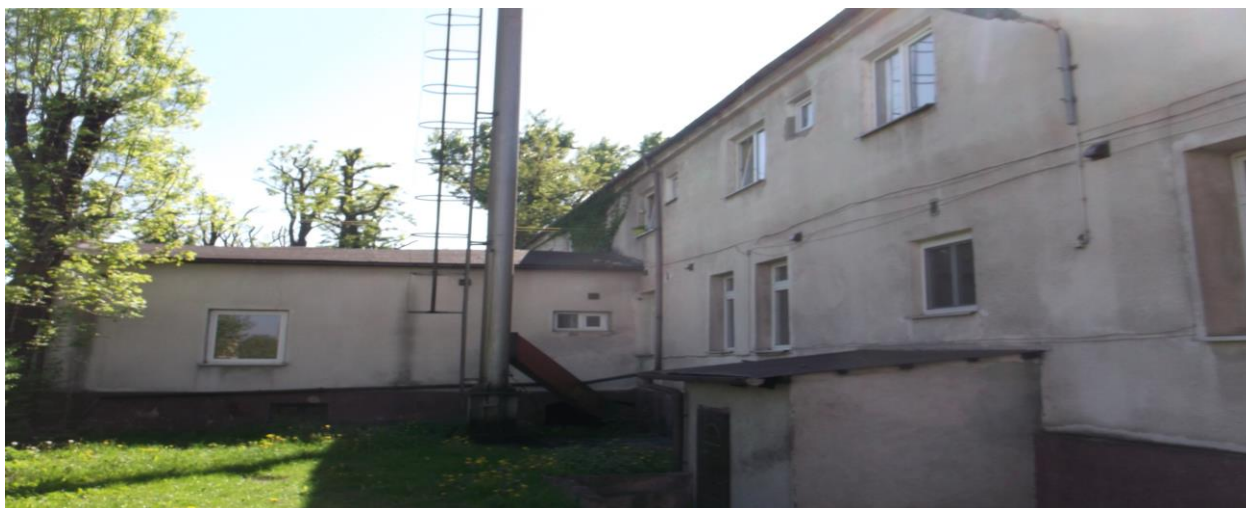
Fot. 4. Elewacja ogrodowa budynku zespołu parkowo dworskiego, stan kwiecień 2018 r.
