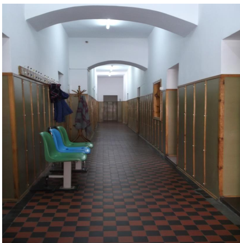
Fot. 7. Stan wewnętrzny budynku zespołu parkowo dworskiego w Piotrkowie Kujawskim
