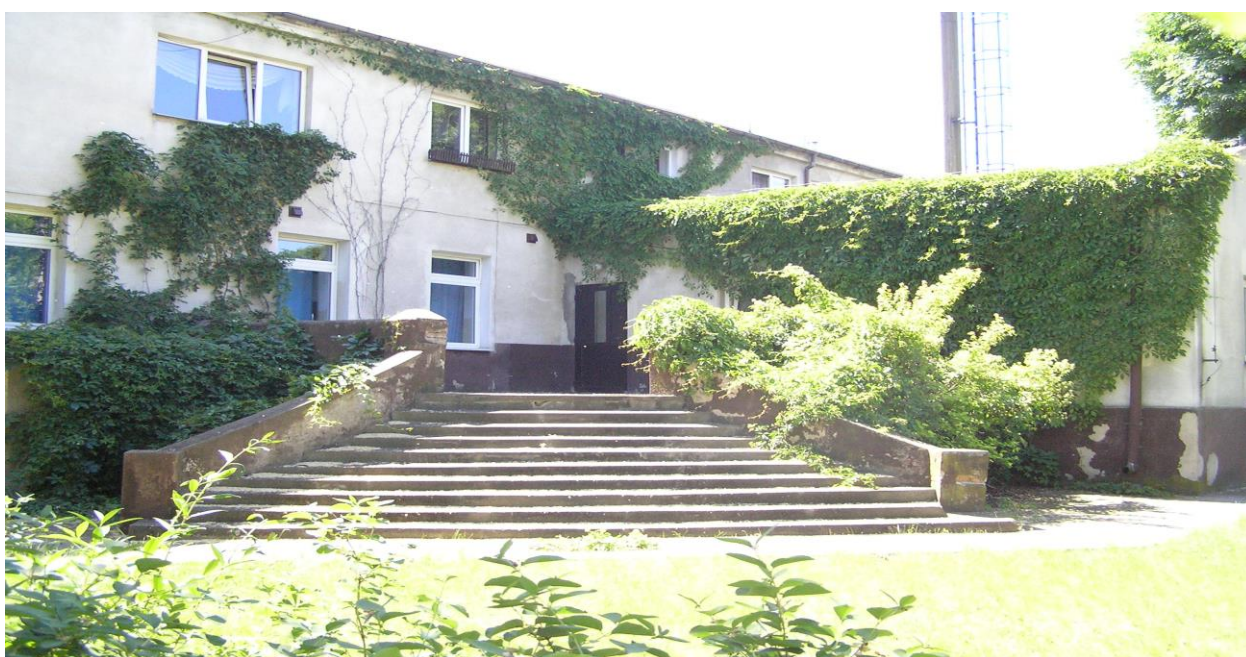
Fot. 6. Wejście do budynku zespołu parkowo dworskiego od strony ogrodu, stan kwiecień 2018r.
