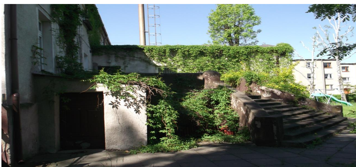
Fot. 5. Elewacja ogrodowa budynku zespołu parkowo dworskiego, stan kwiecień 2018 r.
