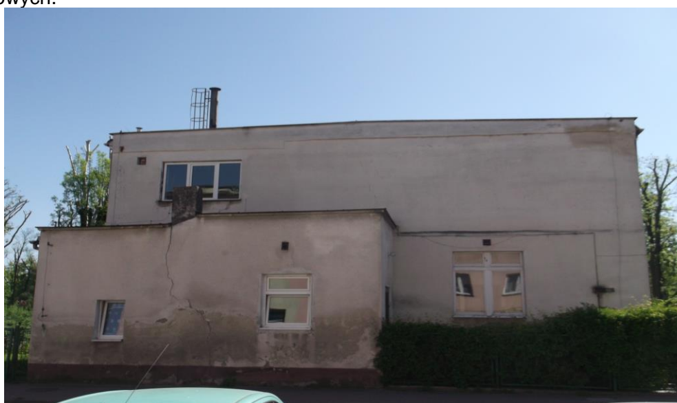
Fot. 3. Elewacja boczna budynku zespołu parkowo dworskiego, stan kwiecień 2018r.
